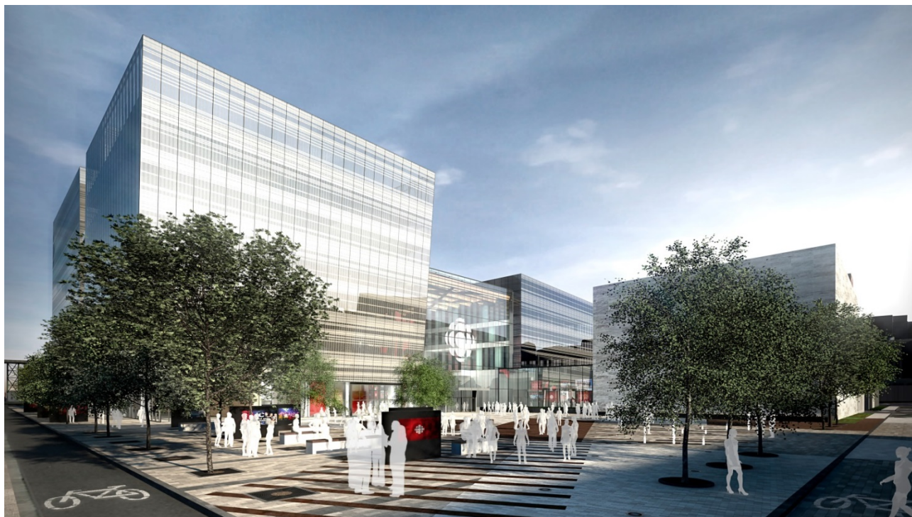
Le chantier s'active et la nouvelle Maison de Radio-Canada prend tranquillement forme.
