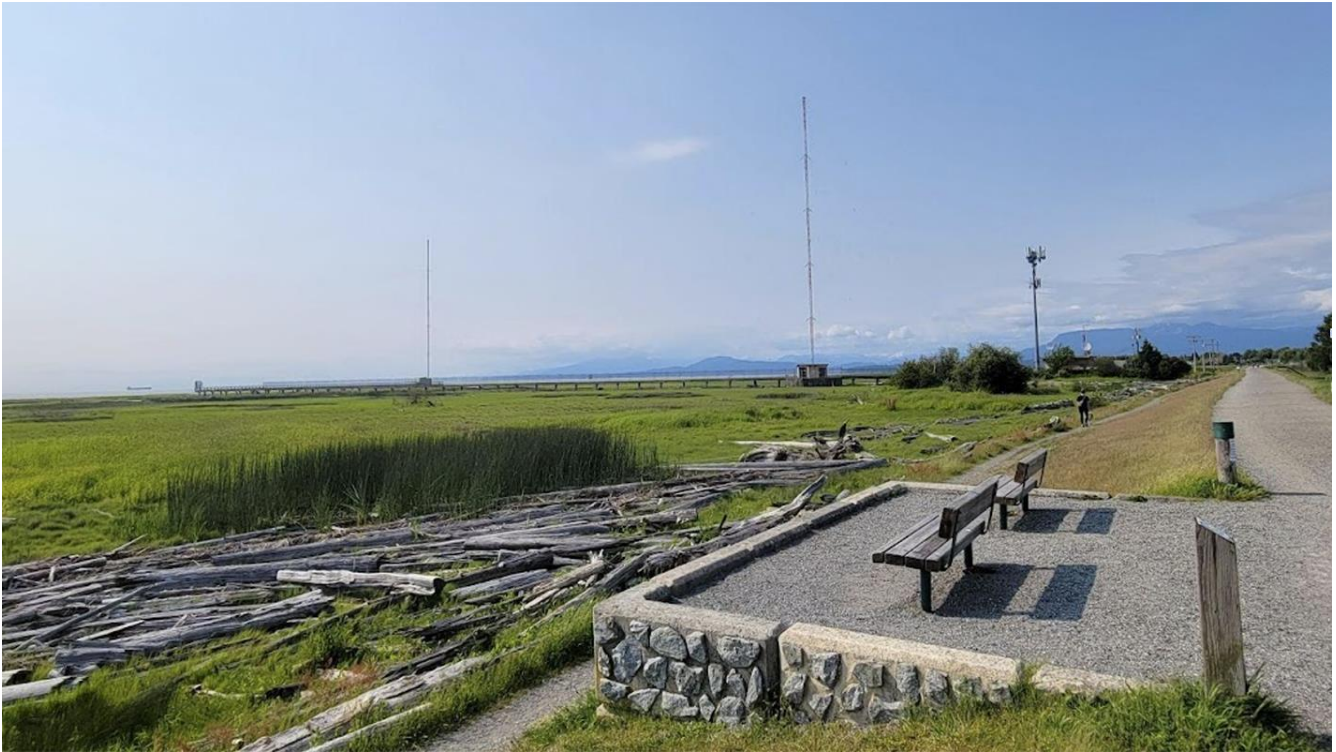
Les deux pylônes AM restants.
